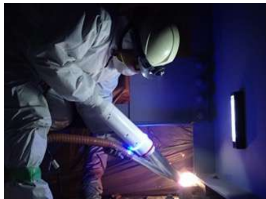
玉鉾橋施工の様子
